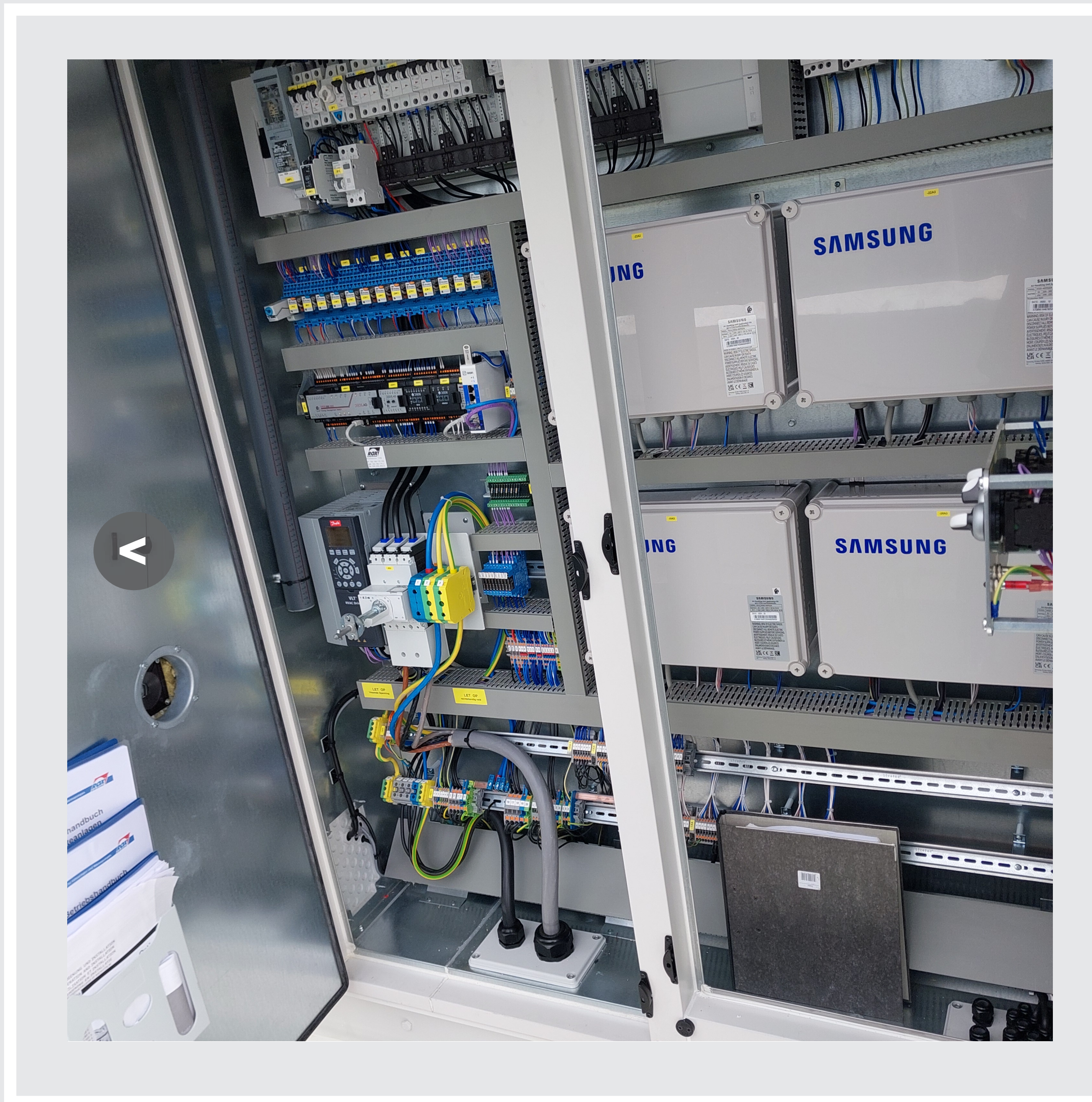
Referenz 09/2024 // Restaurationsbetrieb Kerkrade NL X Bild 3 von 3
